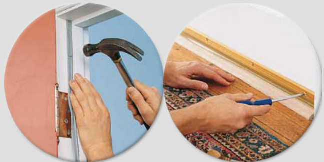
Door draught proofing
